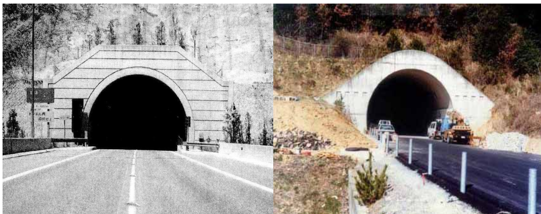
[해설 사진 2.2.58] wing식과 아치 wing식 갱문의 사례
