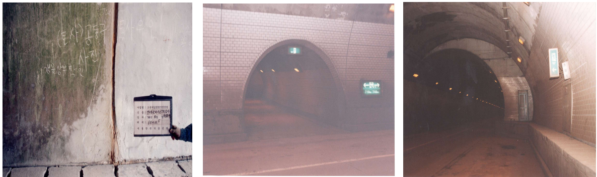
[해설 사진 2.2.18] 라이닝 콘크리트 시공이음부, 횡갱, 대피소의 사례
