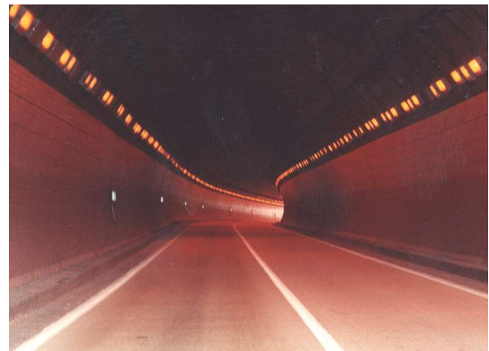
[해설 사진 2.2.20] 터널내장재 전경
