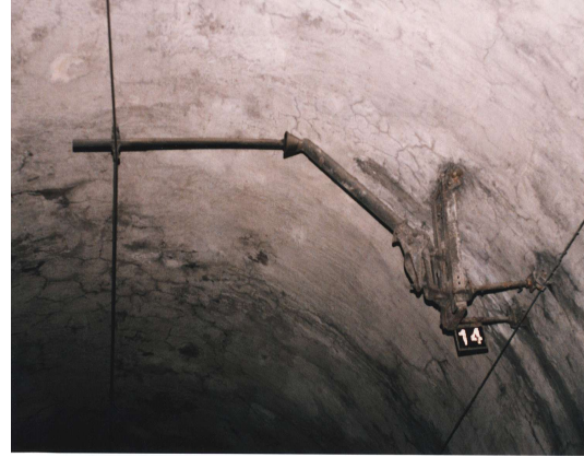
[해설 사진 2.2.28] 단선 철도터널의 브라킷
