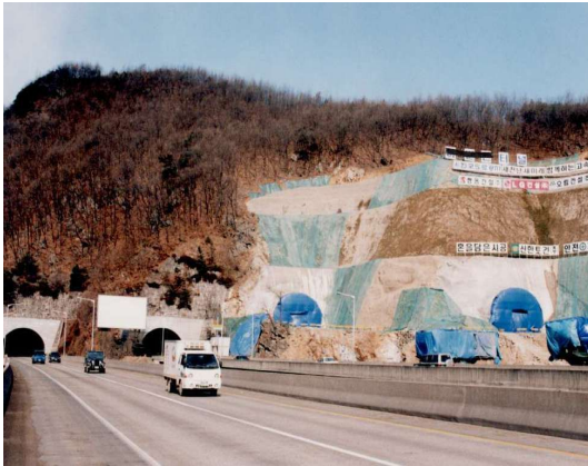
[해설 사진 2.2.43] 근접시공 사례 (터널병설) [해설 그림 2.2.28] 근접시공 사례 (터널교차)
