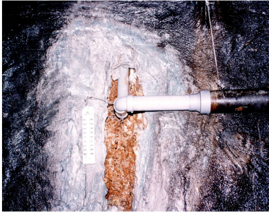
[해설 사진 2.2.8] 누수로 인한 모르터 유실
