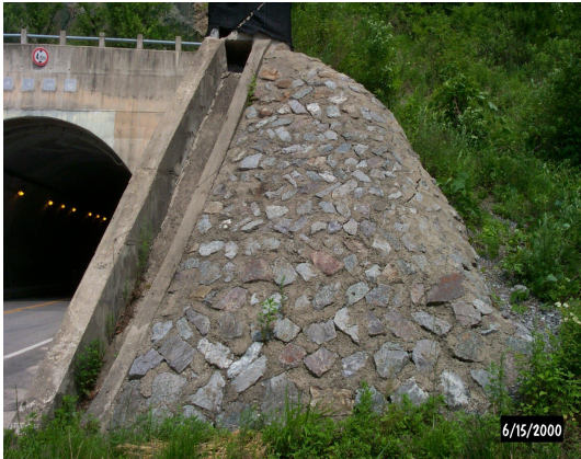
[해설 사진 2.2.35] 갯문측면 보호공 (석축)
