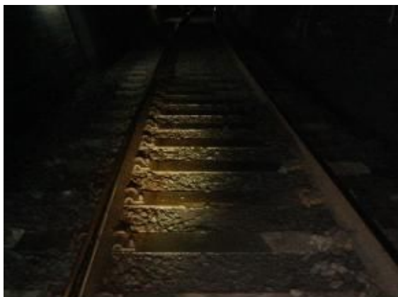
[해설 사진 2.2.6] 철도터널 도상 누수 전경
