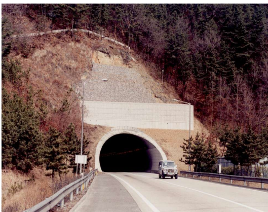
[해설 사진 2.2.33] 갯문상부 보호공 (석축+옹벽공)
