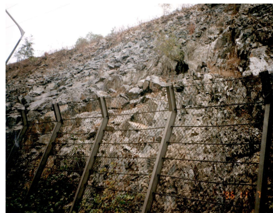
[해설 사진 2.2.32] 도로터널 인접한 대절토사면
