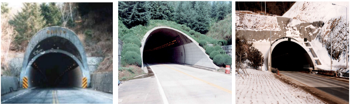
[해설 사진 2.2.59] 돌출형 갭문의 사례 (벨마우스식, 파라페트식, 원통절개식)
