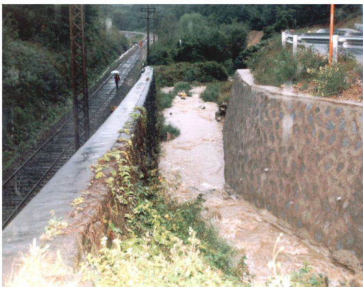
[해설 사진 2.2.39] 옹벽 배면의 배수로
