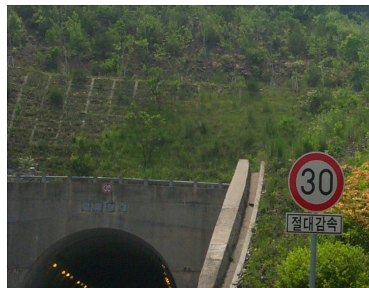
[해설 사진 2.2.34] 갯문상부 보호공 (블록공)
