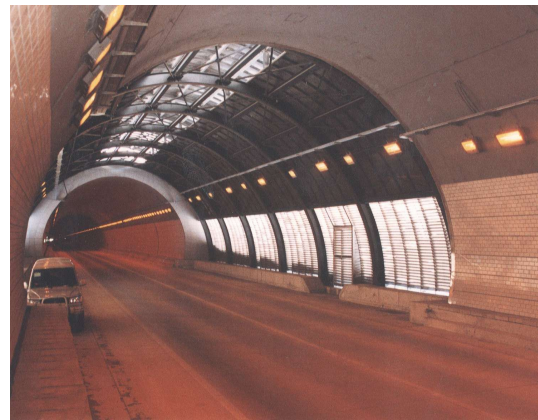
[해설 사진 2.2.22] 터널조명과 개착구간 연결부
