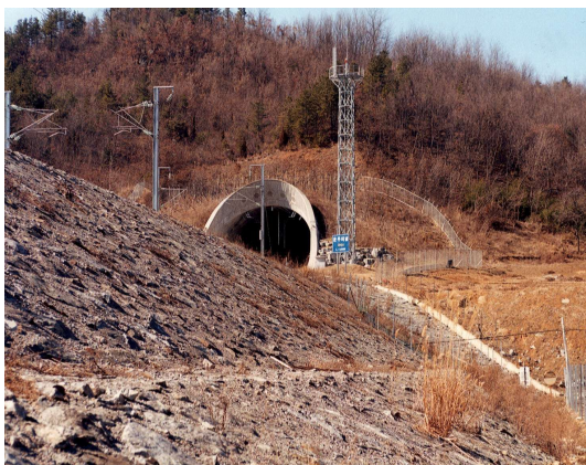
[해설 사진 2.2.31] 고속철도터널 갭문 성토사면
